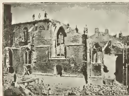
Ancienne Eglise St-Epvre pendant sa démolition.
